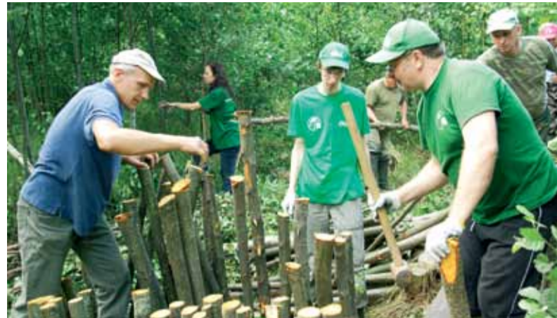
Председатель АПБ Александр Винчевский, специалист по связям с общественностью ИП «Кока-Кола Бевриджиз Белоруссия» Виктор Поздняков и заместитель генерального директора ИП «Кока-Кола Бевриджиз Белоруссия» Андрей Рошупкин ремонтируют плотину на реке Ельнянка
